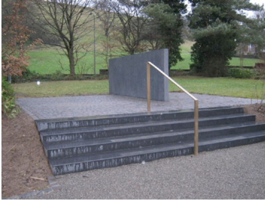
Der Zugang zum neuen Urnen-Gemeinschaftsgrab mit Bronze-Handlauf und stehender Betonscheibe als Schriftenträger
